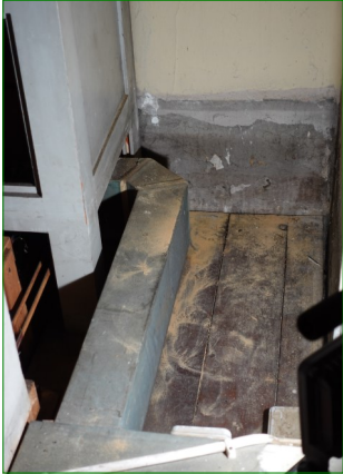
Deutliche Spuren des Holzwurm-Befalls zeigen sich an der Orgel
